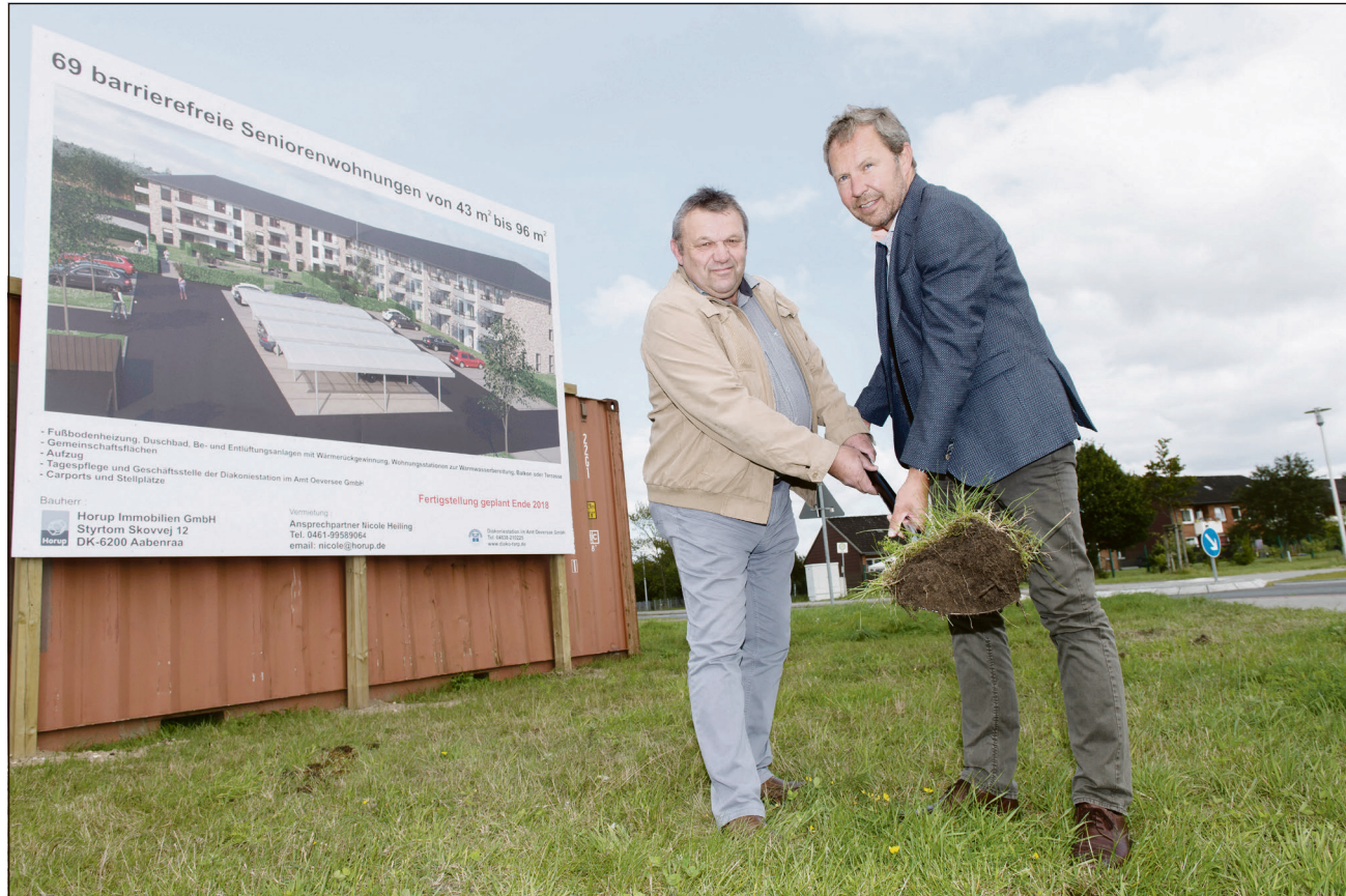
Der danske Investor Per Horup (re.) og Tarps Bürgermeister Peter Hopfstock gaben mit dem Spatenstich das Signal für den Baubeginn einer Senioren-Wohnanlage im Schellenpark. (Fotos: Tim Riediger)
