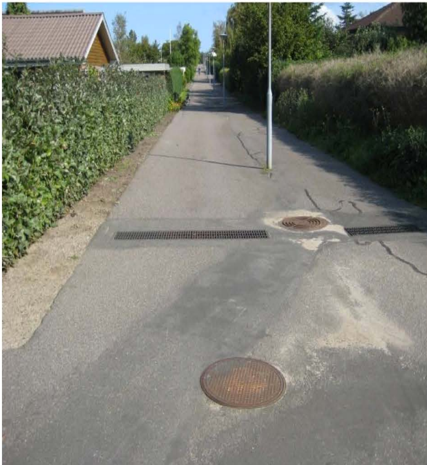
Billede 1. Cykelsti ved Strømøvænget, Middelfart. Før og efter klimatilpasning – regnvandet opsamles mellem de nyetablerede "høje kanter" og ledes kontrolleret til et opsamlingsbassin.
