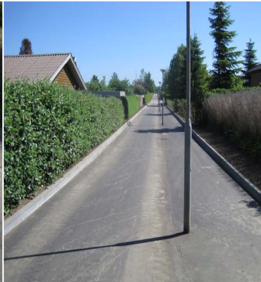
Billede 1. Cykelsti ved Strømøvænget, Middelfart. Før og efter klimatilpasning – regnvandet opsamles mellem de nyetablerede "høje kanter" og ledes kontrolleret til et opsamlingsbassin.
