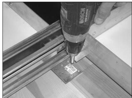
Sokkel-ende skal flugte med møtrikker, hvis endegavl skal monteres.
